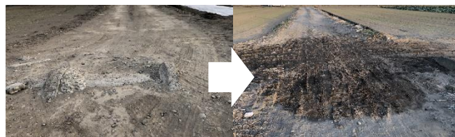
市道(農道)内の障害物を 除去していただきました
