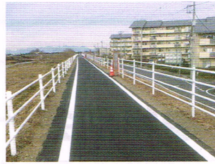
天満橋から豊東橋の間、サイクリングロードが舗装整備されます(まゆドーム周辺が2月現在工事中)
